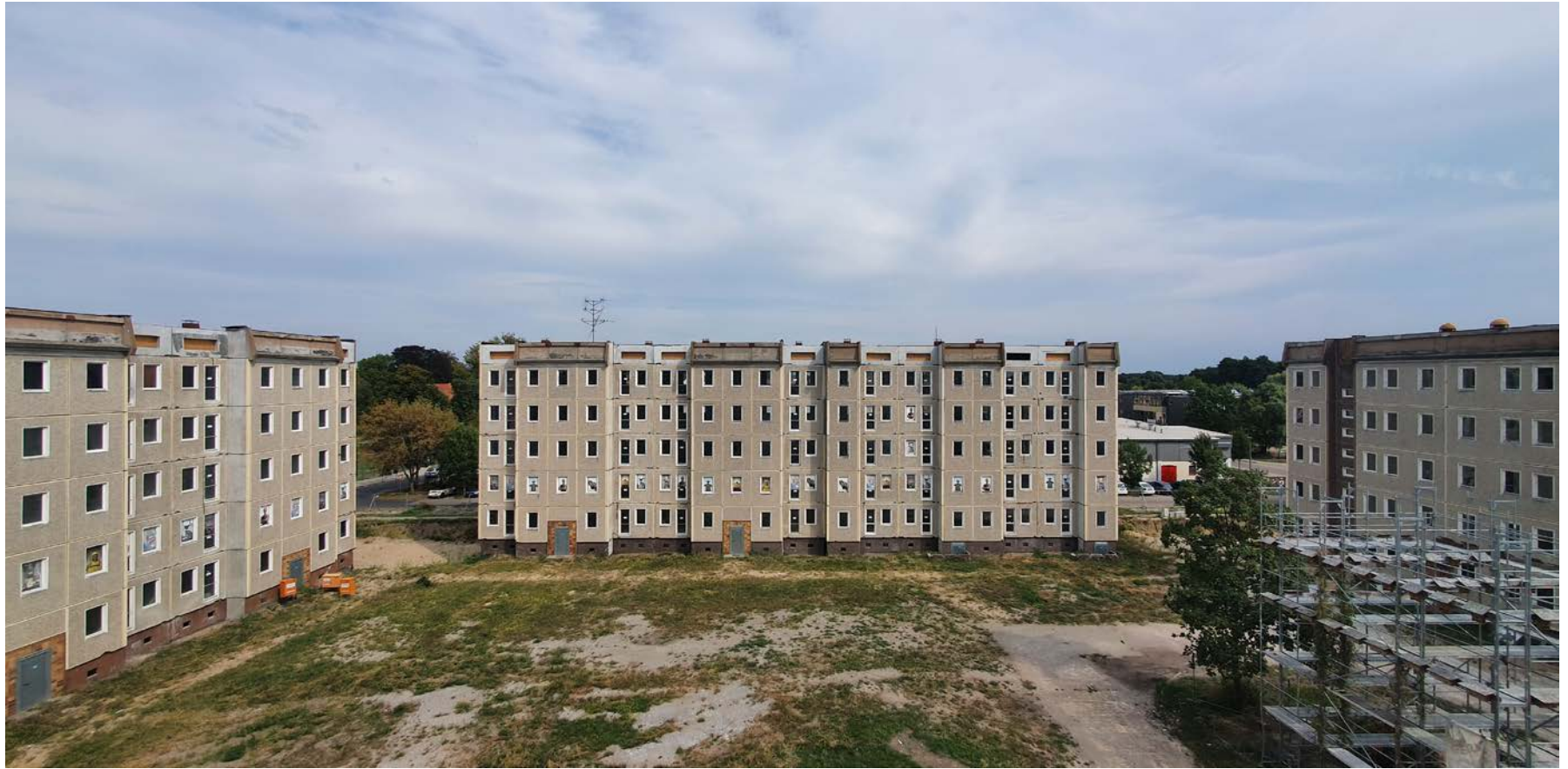
Luckenwalde Bestandssituation nach Rückbau und Entkernung
