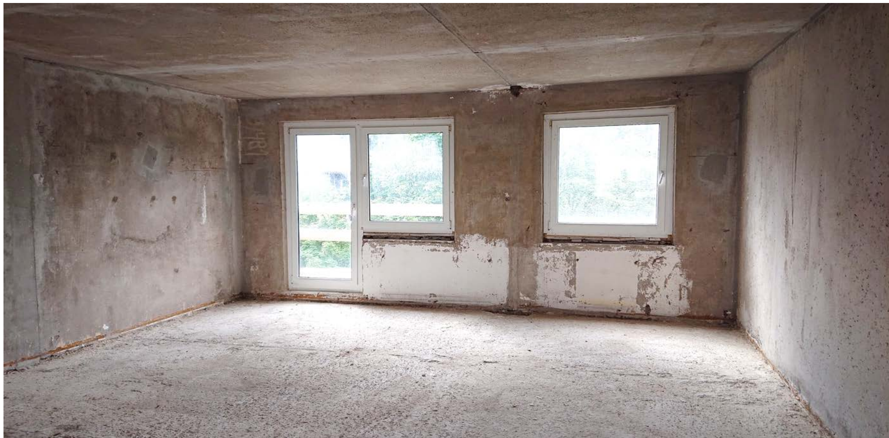
Luckenwalde Bestandssituation nach Rückbau und Entkernung
